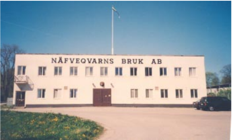
Näveksvarns bruk, huvudbyggnaden.
